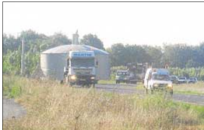
Les cuves de Boisseron ont été découpées et déplacées à Gallargues.
